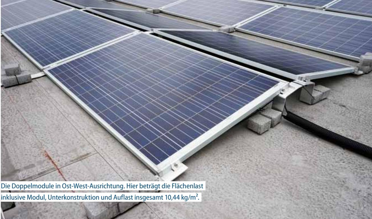
Die Doppelmodule in Ost-West-Ausrichtung. Hier beträgt die Flächenlast inklusive Modul, Unterkonstruktion und Auflast insgesamt  $10,44 \text{ kg/m}^2$ .
