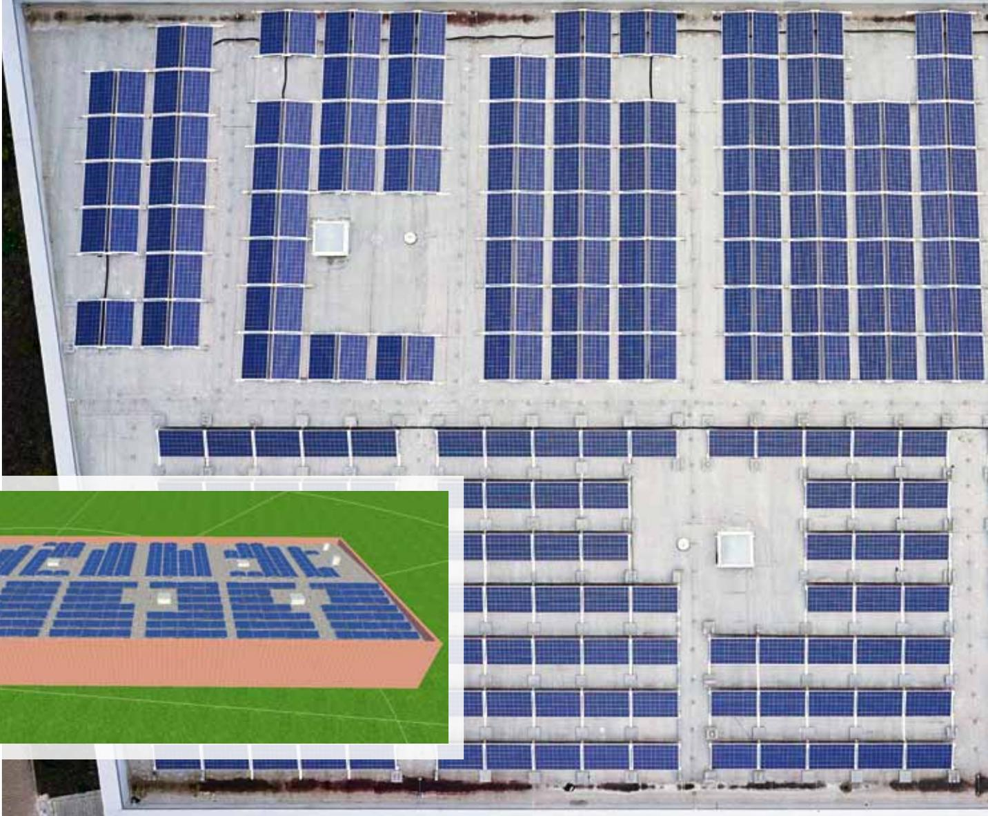
Von den insgesamt 381 eingesetzten Modulen sind 153 Richtung Süden ausgerichtet. Die Ost- und Westfläche besteht aus jeweils 114 Modulen, die alle nach einem genauen Verlegeschema (siehe Einklinker) montiert wurden.
